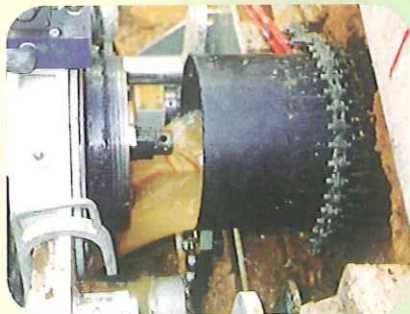
管内排土状況
