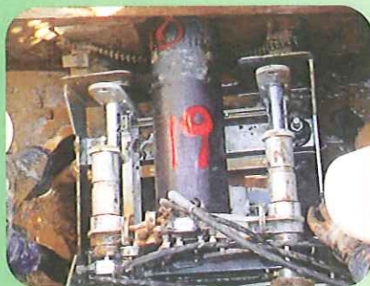
鋼管推進状況
