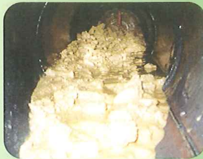
管内ズリ状況
