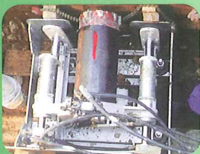
掘削ヘッド発進状況
